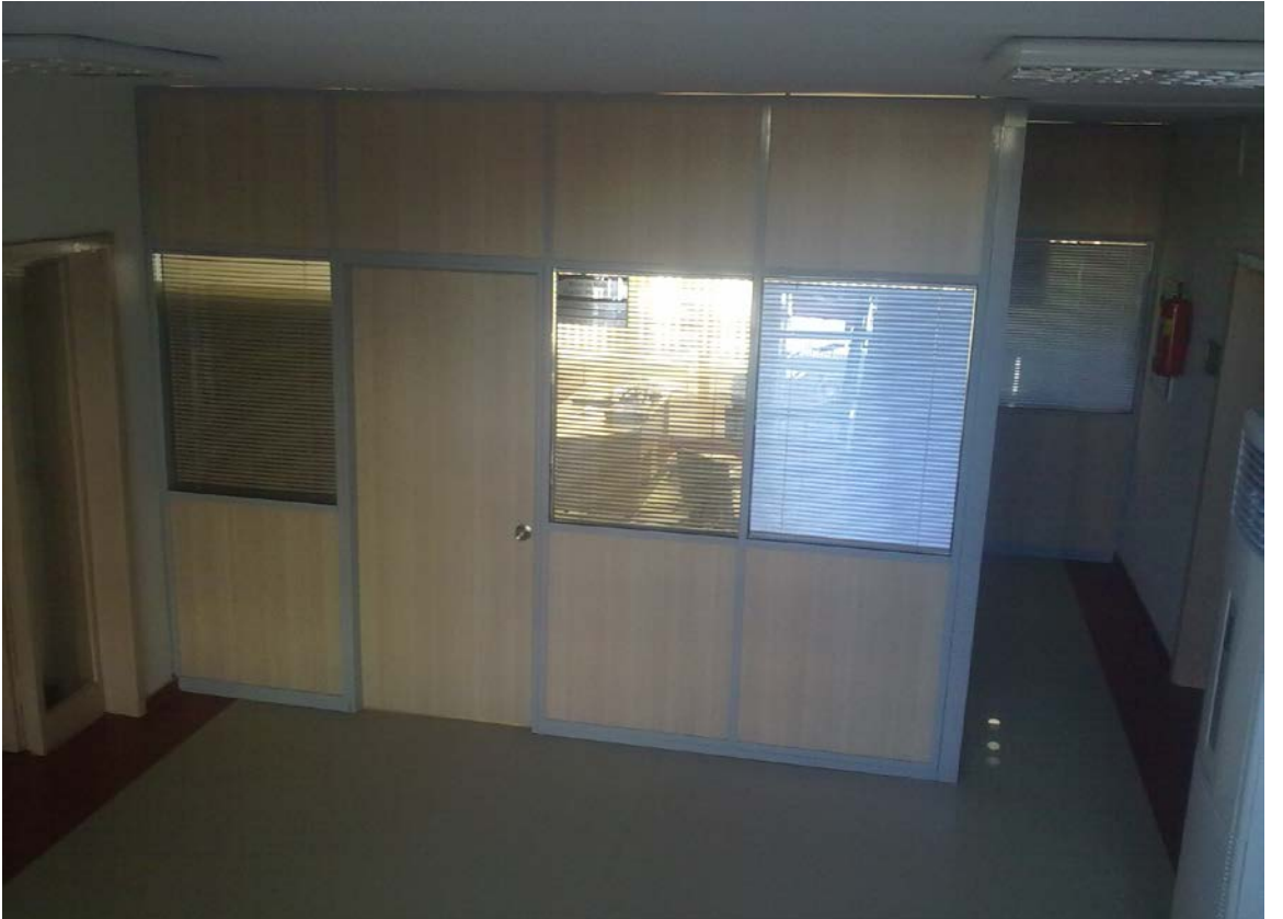
Göztepe binası yeni ek oda bölmesi yapım işi:
